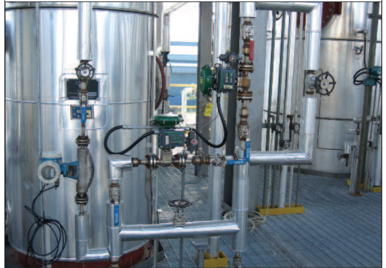
DESODORIZADOR Y COLUMNA DE CRUDO
